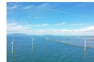
秋田港洋上風力発電所※
